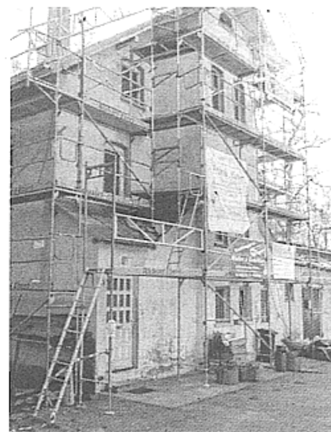
Der Lindenhof ist gerade eingerüstet und wird saniert.
